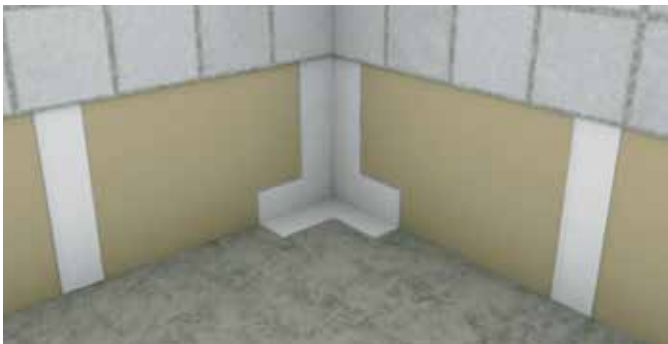
1. Levitä vedeneristettä nurkkakappaleen alueelle.
